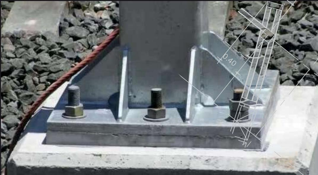
TKZ GROUT 700 está fabricado a base de cemento portland, microagregados minerales y aditivos.
