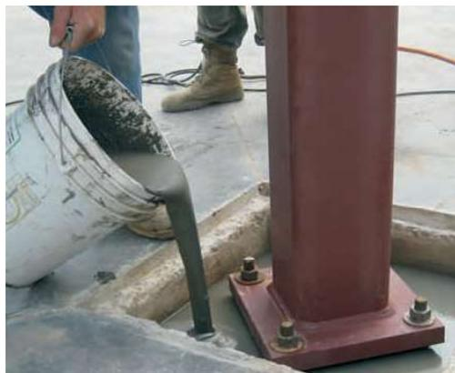
Las reparaciones del soporte, el relleno de oquedades y la nivelación del soporte se llevarán a cabo con los productos adecuados. Toda la suciedad, así como las partes sueltas o mal adheridas, deben ser eliminadas antes de la aplicación del producto, preferiblemente por cepillado y/o aspirado.
