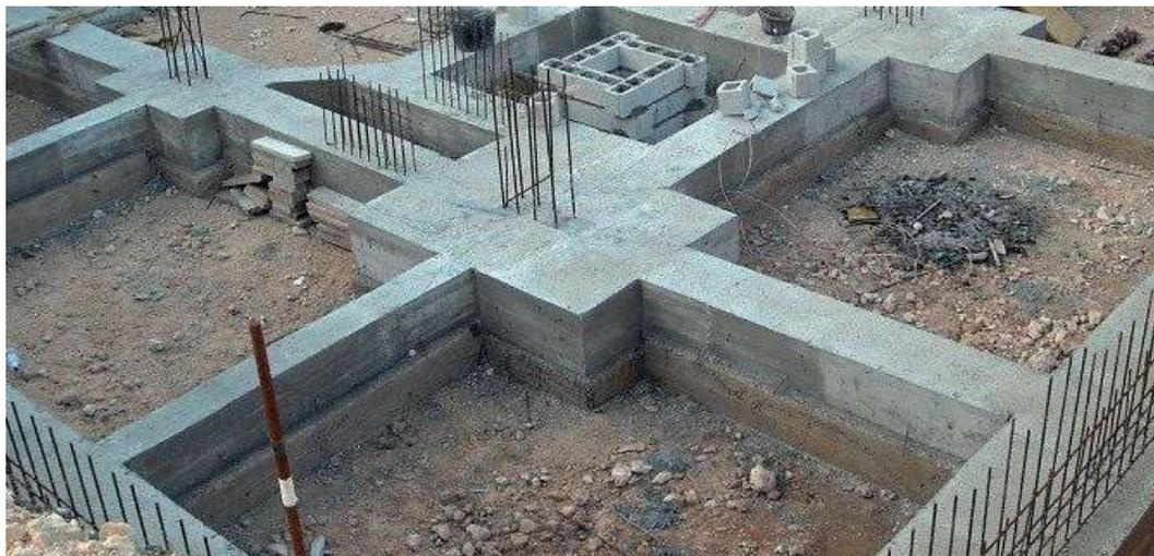
Proteger el material fresco contra el secado prematuro y el agrietamiento mediante un método de curado adecuado, por ejemplo, compuesto de curado, membrana geotextil húmeda, tela de arpillera, lámina de polietileno, etc. En climas fríos, aplique mantas aislantes para mantener una temperatura constante y evitar daños en la superficie por congelación y heladas.
