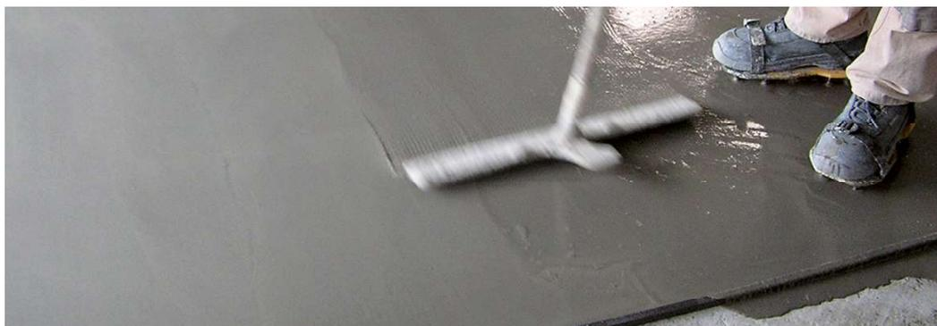
Una vez haya endurecido la imprimación y se haya fijado parte del árido, se barrerá concienzudamente el sobrante de árido. Para el uso de otro tipo de imprimaciones de naturaleza acrílica, consultar con el departamento técnico.
